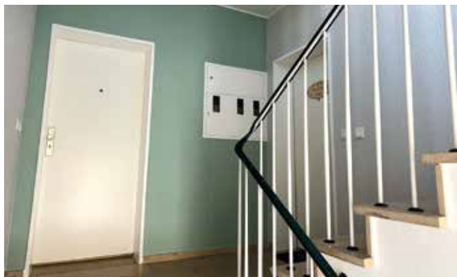
Der neue Treppenhausanstrich
