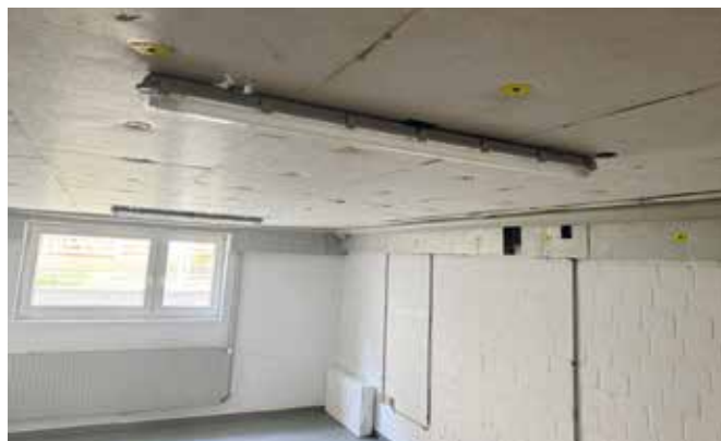
Die nun gedämmte Kellerdecke
